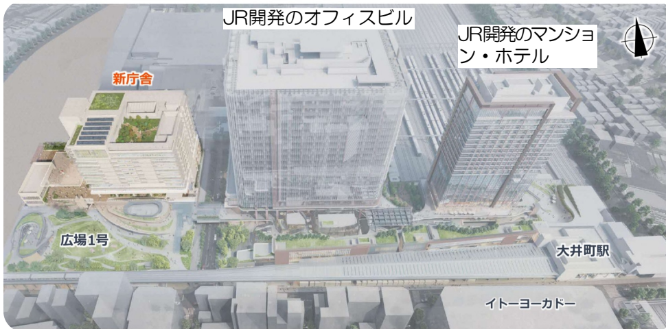
▲左の新庁舎は14階・62m。真ん中のJRのオフィスビルは23階・高さ15m、右のマンション・ホテルは26階・高さ105m。
