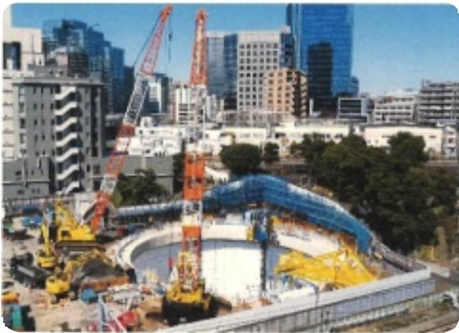
▲北品川非常口の立坑工事写真。既に立坑工事は完了。
