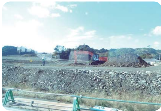
いまだにかさ上げ工事が続く集落
