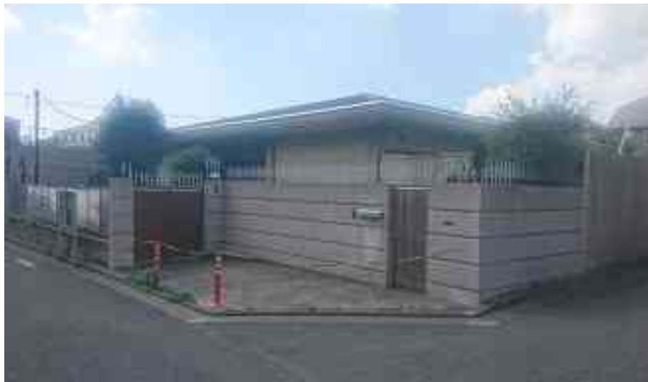
国より品川区に土地取得についての意見照会があった西大井3丁目の国有地(元最高裁判所宿舎)の現在の様子。
