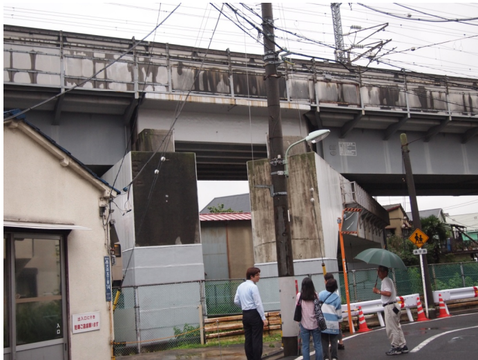
写真は20m道路(29号線)が新幹線下で交差するところ。既に、道路計画幅にあわせて、こっただけ橋脚が斜めに設置されています。
