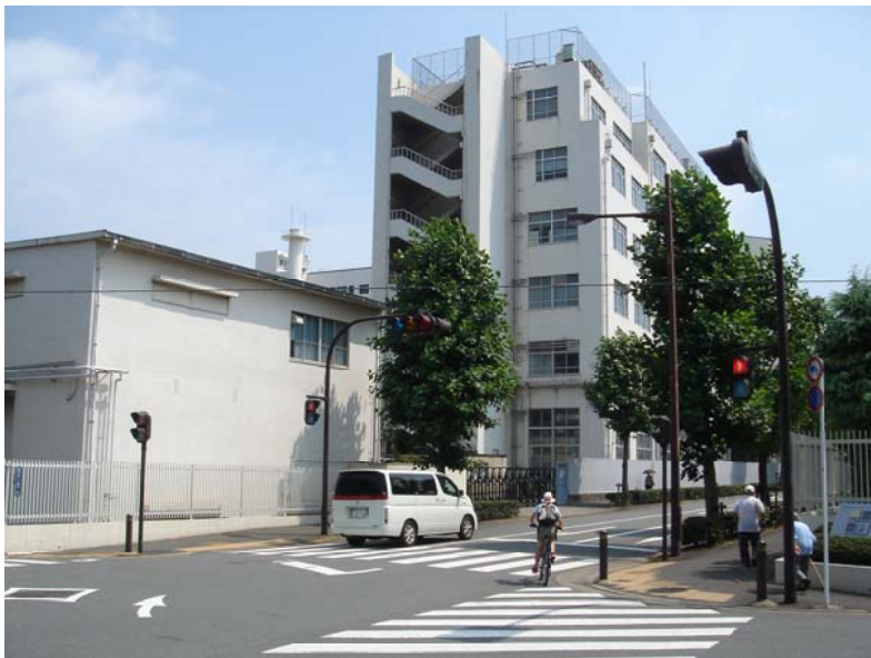
解体される建物の1つである103号館(地上6階地下1階)
