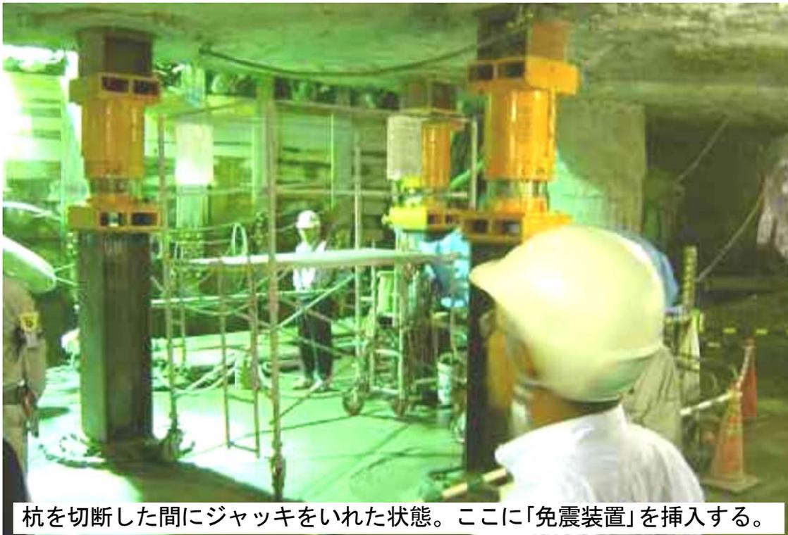
杭を切断した間にジャッキをいれた状態。ここに「免震装置」を挿入する。
