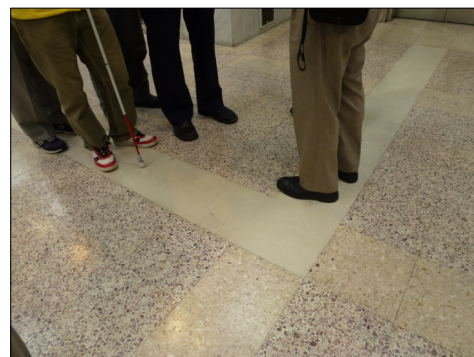
きゅりあんの中。エレベーターへの点字ブロックがありません
