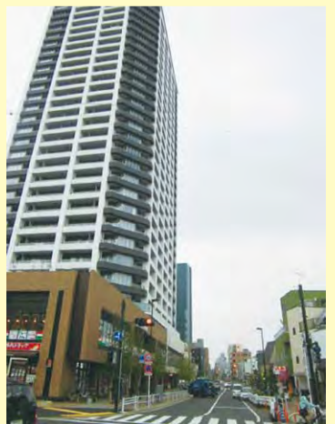
大井町西地区再開発ビル
